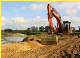
Bagger im Einsatz
