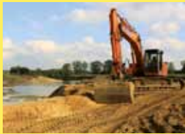
Bagger im Einsatz
