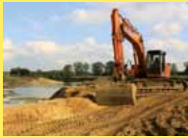
Bagger im Einsatz
