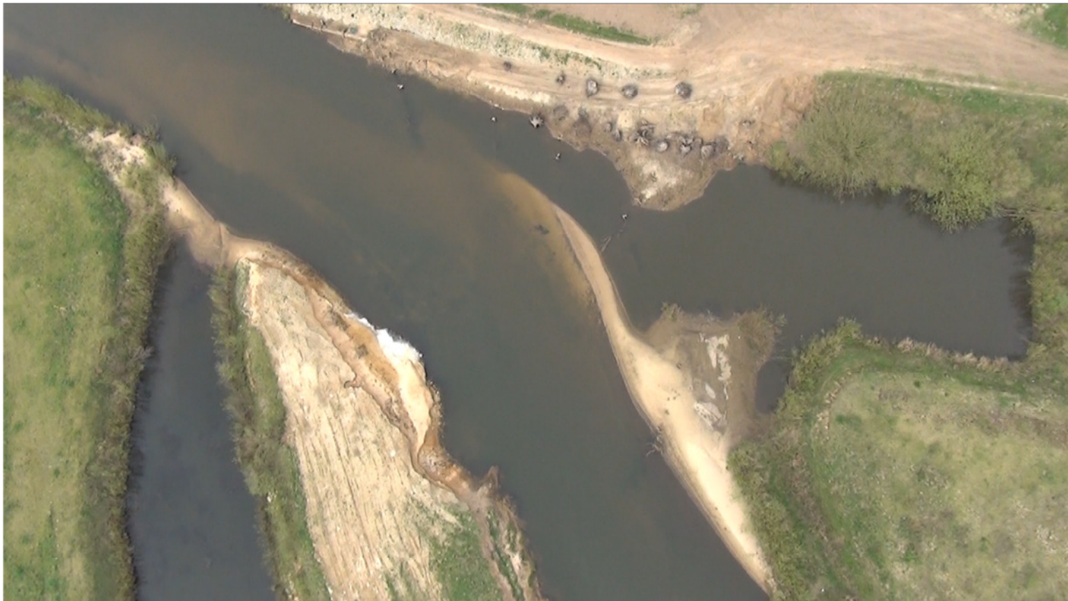
nach Einbau Buhnen
