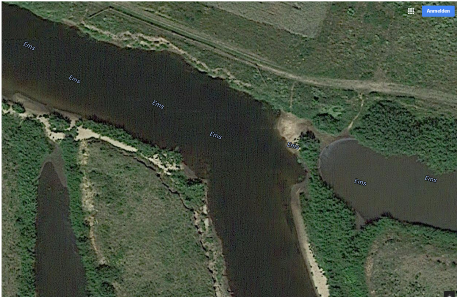
vor Einbau der Buhnen
