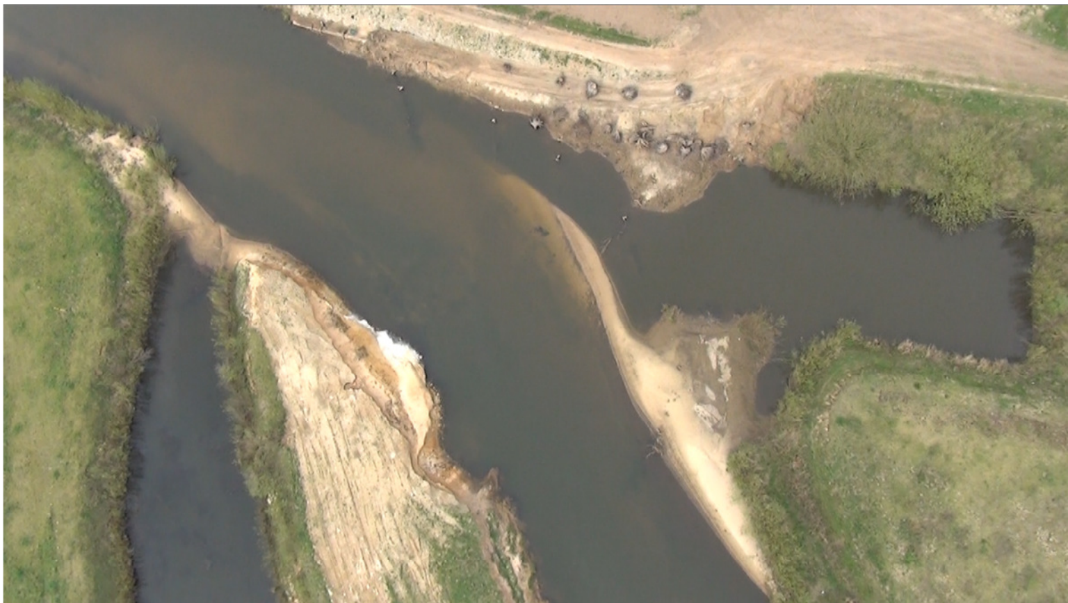
nach Einbau Buhnen
